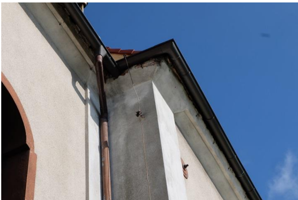
Rys.4. Uszkodzony gzyms.
