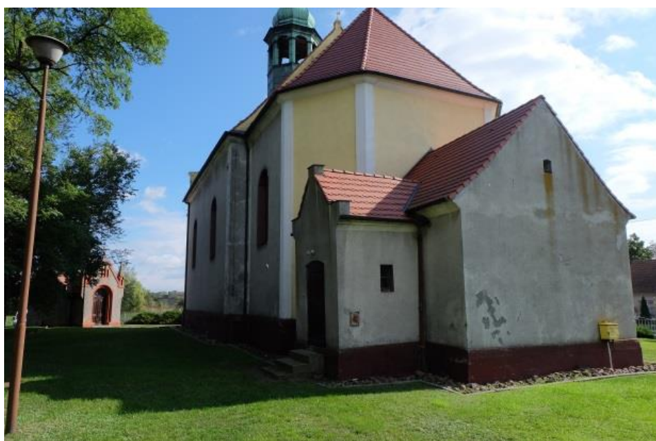
Rys.3. Widok – ściana północna
